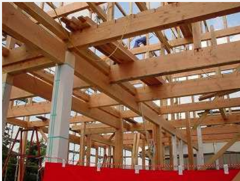
長尺物の梁材を使用した事例
